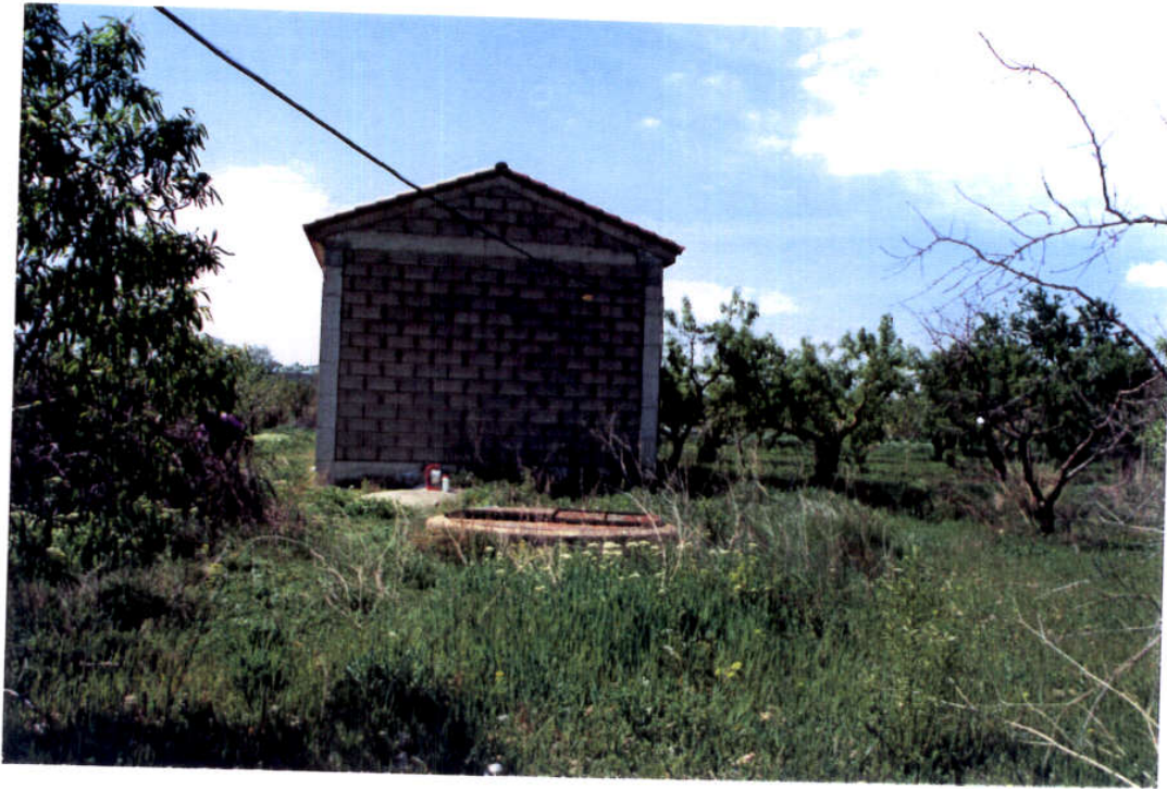
FOTO 1: Captación de aguas subterráneas.
